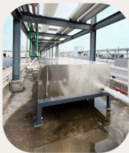
在屋頂安裝新型儲水箱並翻新管道基礎設施，以支持廢水回用
