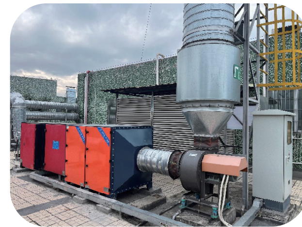
2025年，我們位於中國沙井的工廠將六套UV系統更換為活性炭裝置，進一步提升了VOC的減排效果
